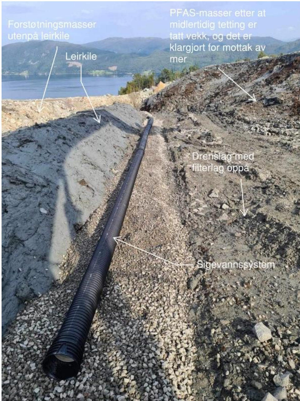
Figur 13: Sivevannssystem mot leirkile i nord i PFAS-celle.
