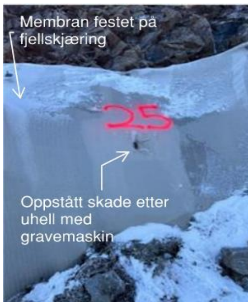
Figur 11: Bildene over viser utførelse av lapping ved funn av skade. Bilder tatt 17. Februar 2025.
