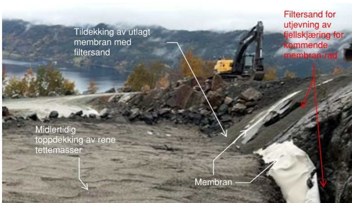
Figur 7: Midlertidig toppdekke er etablert i PFAS-celle.
