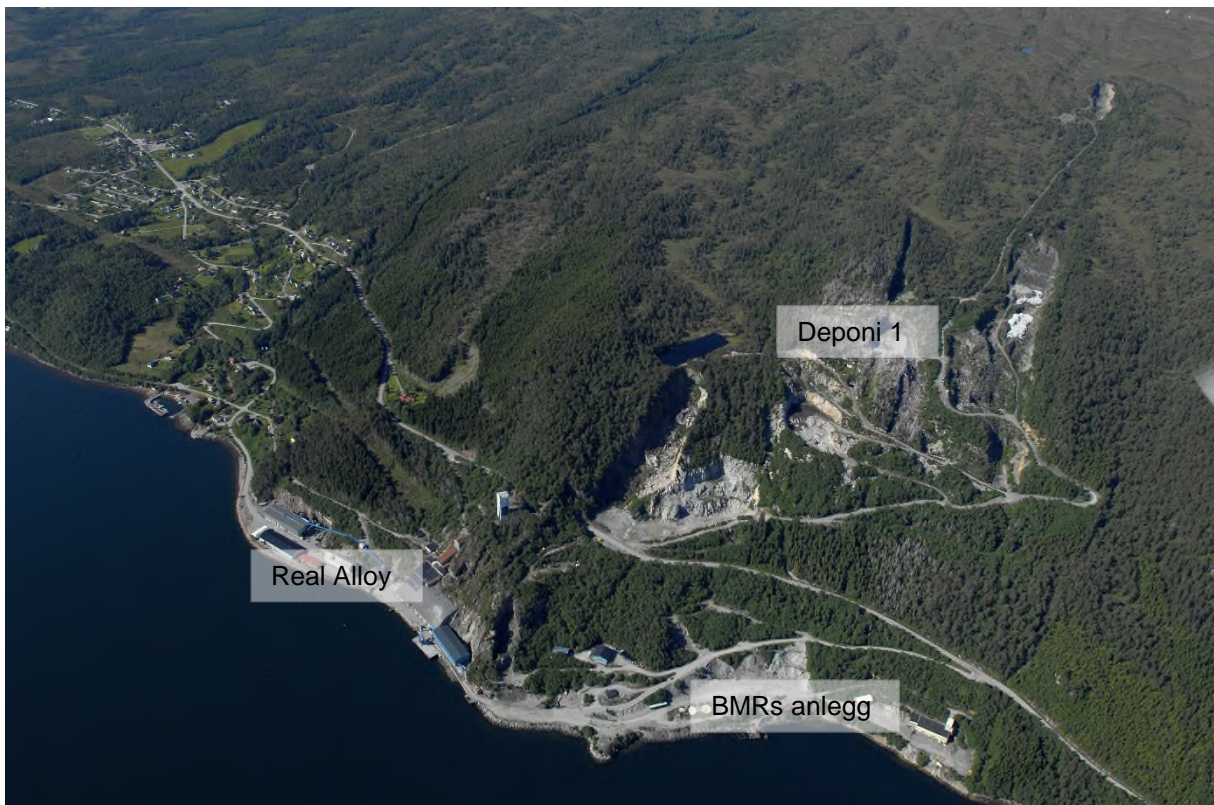
Figur 2-1 - Oversiktsbilde som viser dagens virksomhet på Raudsand. Foto: Øyvind Leren
