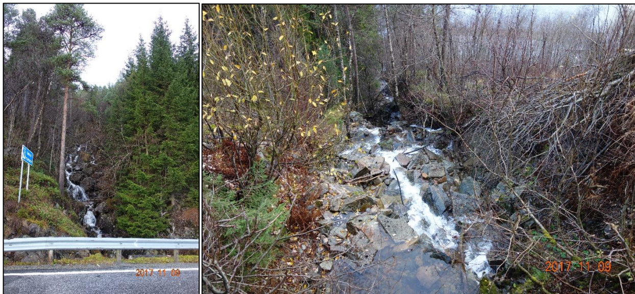
Figur 14: Hållåvåbekken. Til venstre: bekkeløp på oversiden av fylkesveg. Til høyre: Bekkeløp på nedsiden av fylkesveg. Sidekanter er berg, en del stein i selve løpet.
