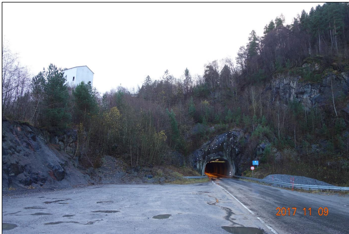
Figur 21: Oversiktsbilde som viser terreng i overkant av tunnel og planlagt administrasjonsbygg. Bygget planlegges plassert til venstre i bildet, nedenfor det hvite tårnet.
