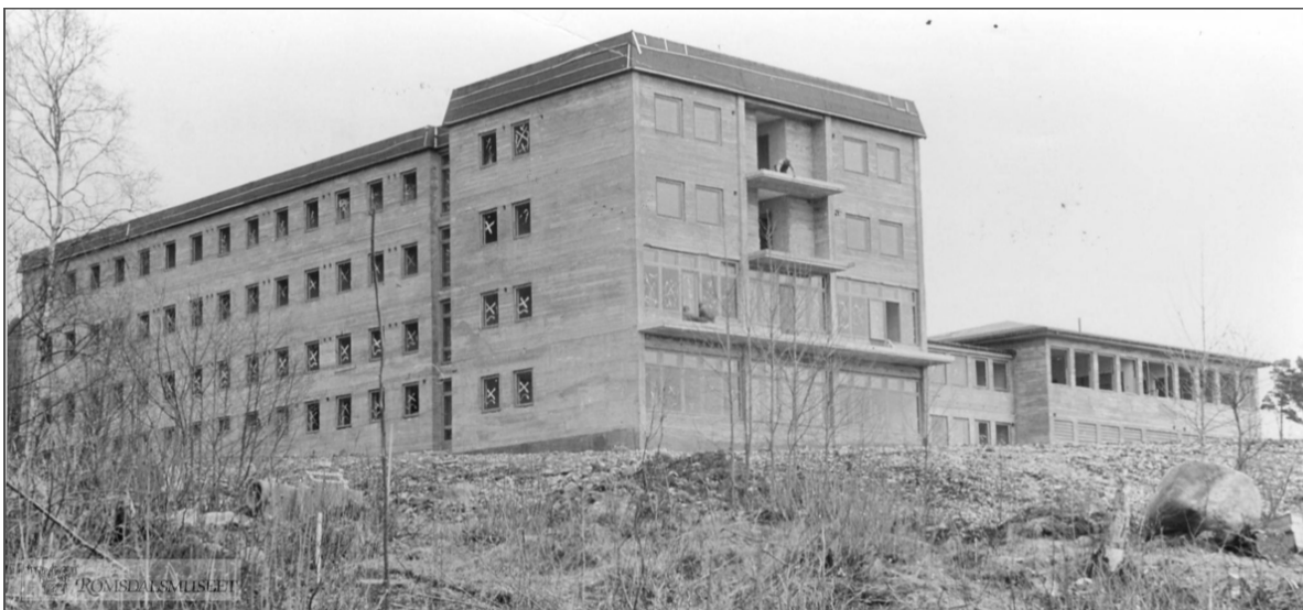
Figur 4--1: Sykepleierskolen under i bygging
