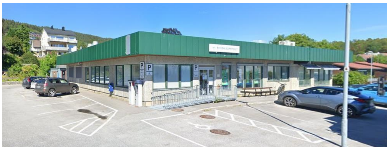
Figur 4-9 Sykehusapoteket Parkvegen. Byggeår 1974, oppført i betongelementer. Google Street view juni 2022.
