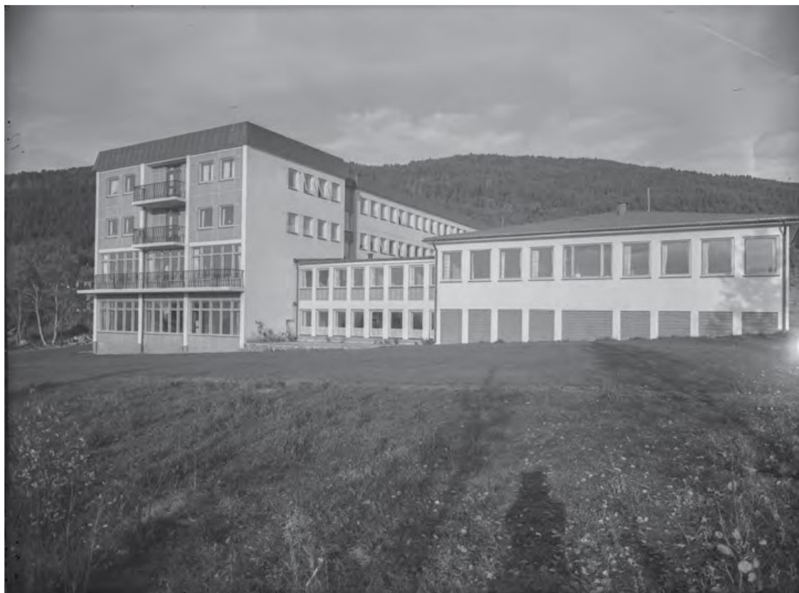
Figur 4-4 Sykepleierskolen. Kilde Romsdalsmuseet, ukjent årstall. Det er bare fløyen til venstre i bildet som er kommunalt listeført.
