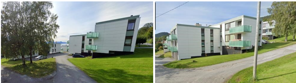
Figur 4-6 Lundabo Borettslag, Bjørnstjerne Bjørnsons veg. Informant hos kommunen oppgir arkitekt Knut P. Bugge som arkitekt for sykepleierboligene. Yttervegger ble rehabilitert i 2009. Nye balkonger i grønnfarget platemateriale. Google Street View sept. 2019.
