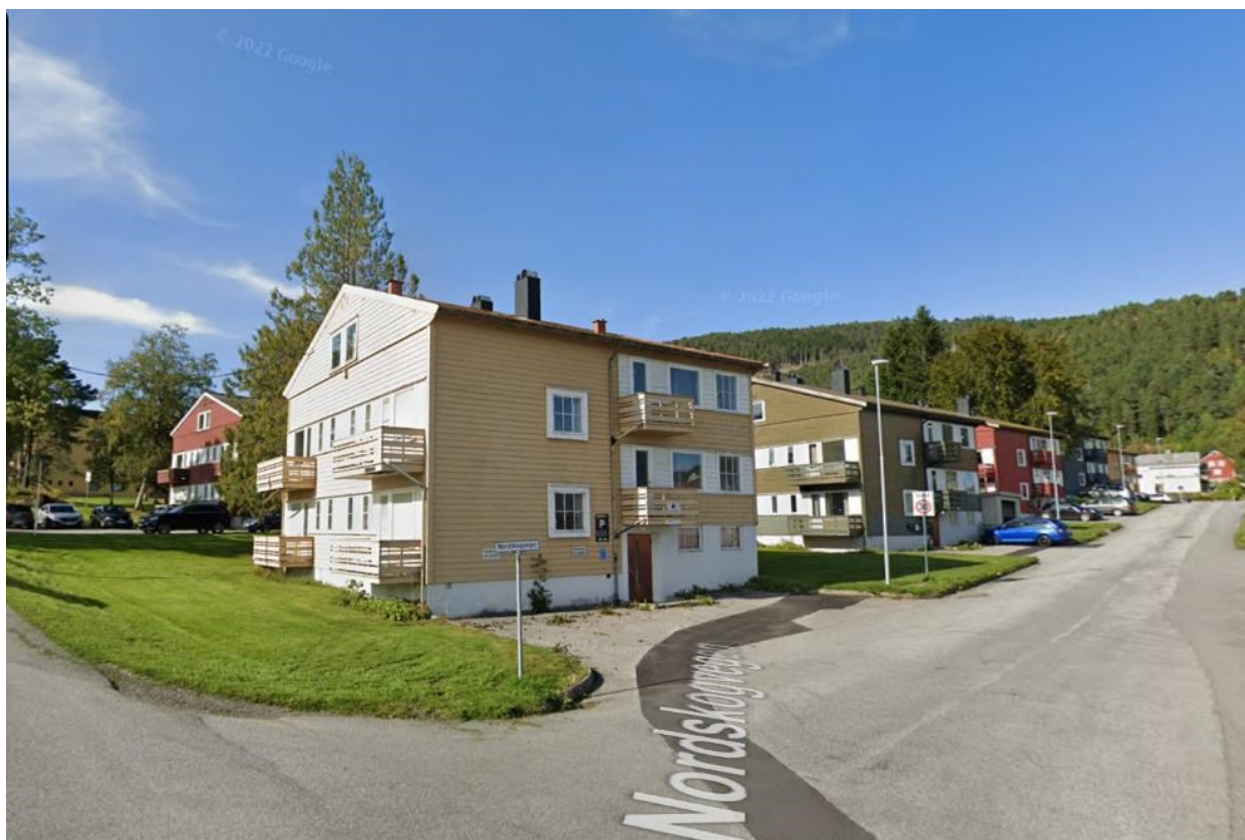
Figur 4-10 I bildet ser vi Glomstuvegen 14 og 18 lengst fremme i bildet og de øvrige punkthusene i Nordskogvegen 1-3-5-7. Google Street view sep.2019.
