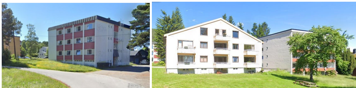
Figur 4-11 Personal- og studentboliger på Stuevollen tegnet av arkitekt Ivar Bjordal. Stuevollvegen 3 i bildet til venstre er bygget som hybelhus for ansatte (Stuevollvegen 3, 4 og 6). «Søsterboligene» i Stuevollvegen 1 og 2, i bildet til høyre, er oppført i 1961. Google Street view juni 2022.
