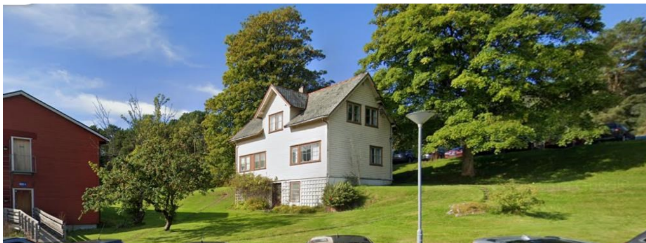
Figur 4-8 Eldre trehus på Fylkessykehusets tomt, Glomstuvegen 15 gnr. 23 bnr. 95. Google Street View sept. 2019. Huset skal flyttes til Romsdalsmuseet.
