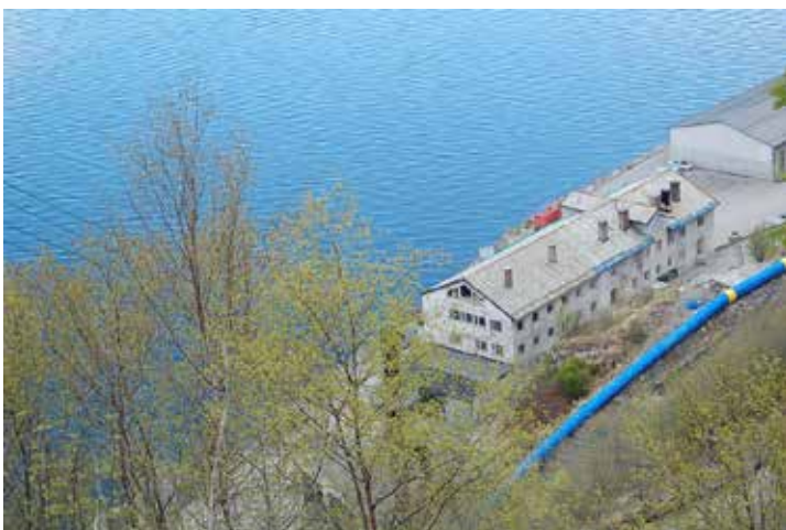
Figur 25: Biletet er teke frå toppen ved heisetårnet. Biletet syner det som var verkstad og administrasjonsbygg då gruva var i drift. Det er i dag omkransa av moderne industribygg.
