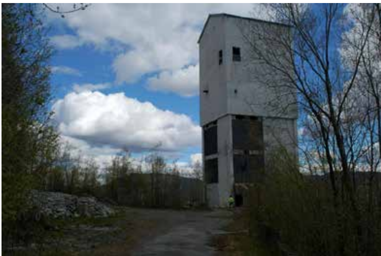
Figur 22: Heisetårnet ligg 101 moh i enden av ein smal asfaltveg som går opp like ved tunellmunningen ved Fv666.
