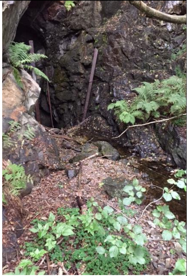
Figur 3-6 b) Inntak topp sjakt og enden av kanalen
