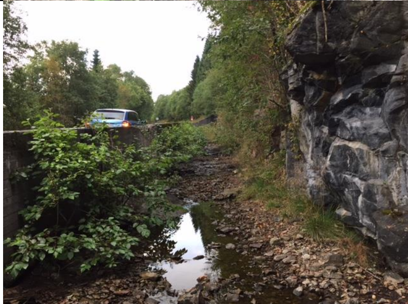
Figur 3-7 b) Kanal bak mur ved FV 666, sett oppover
