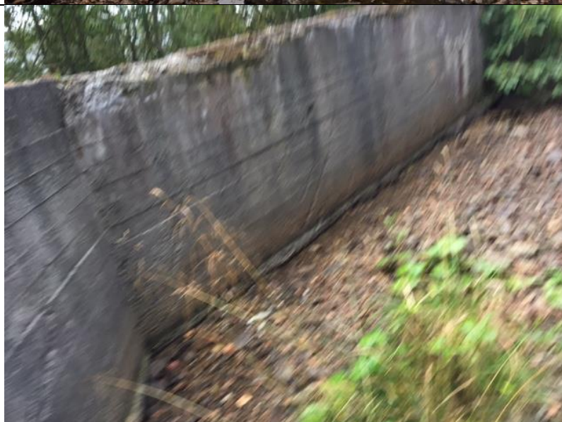
Figur 3-7 c) Kanal bak mur, nedre del, hvor den svinger inn mot sjakten
