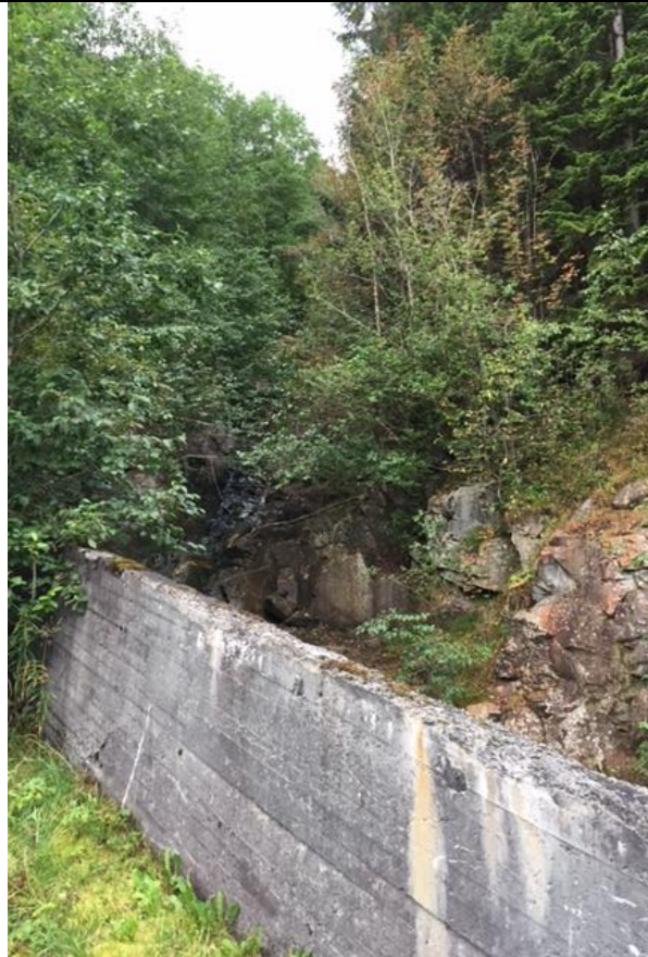
Figur 3-6 a) Bekkeløp ned mot start kanal. Bart fjell i bekkeløp
