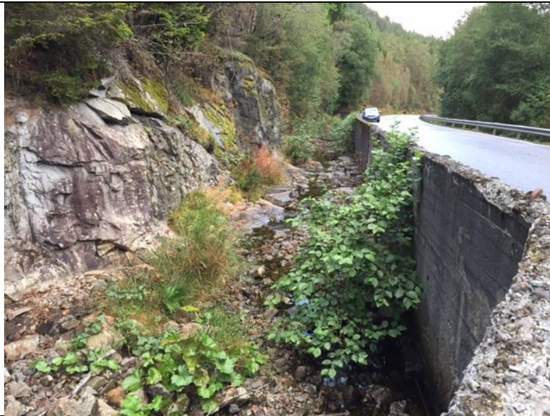
Figur 3-7 a) Kanal bak mur ved FV 666, sett nedover
