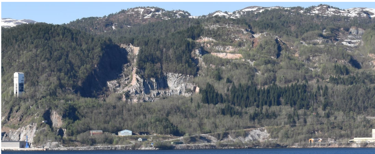
FIGUR 9 STORE SÅR ETTER INNRASING I GRUVENE OG GRUVEDRIFT I DAGBRUDD. ÅPENBART DÅRLIG FJELL MED MYE SPREKKER. OPPE TIL HØYRE SEES FYLLINGER MED BIG-BAGS (DEPONI 2).
