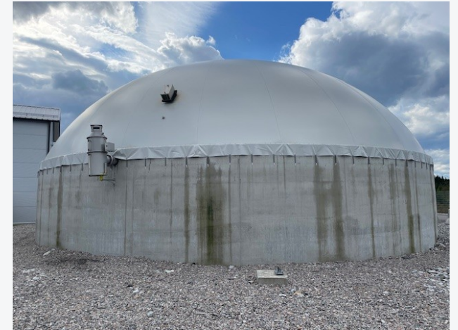
Overføring til biogjødseltank
