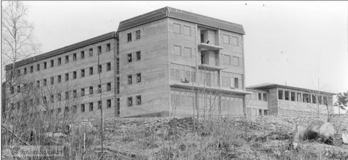
Figur 2-3: Sykepleierskolen under i bygging
